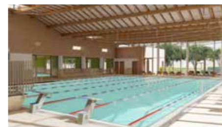
Sportbecken 25x16m mit Sprunganlage (1m-Brett und 3m-Plattform)
